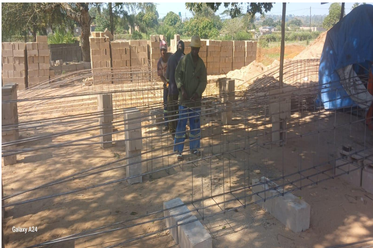
Preparação de vigas e pilares
