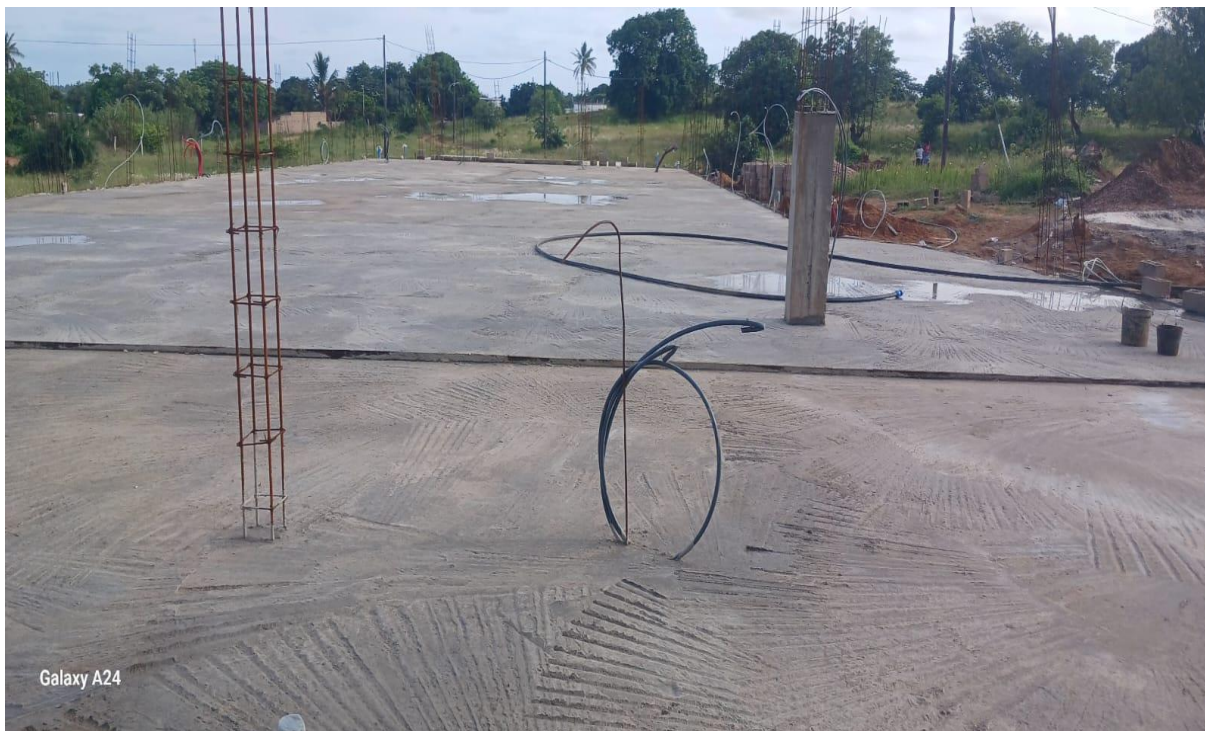
O chão já pavimentado
