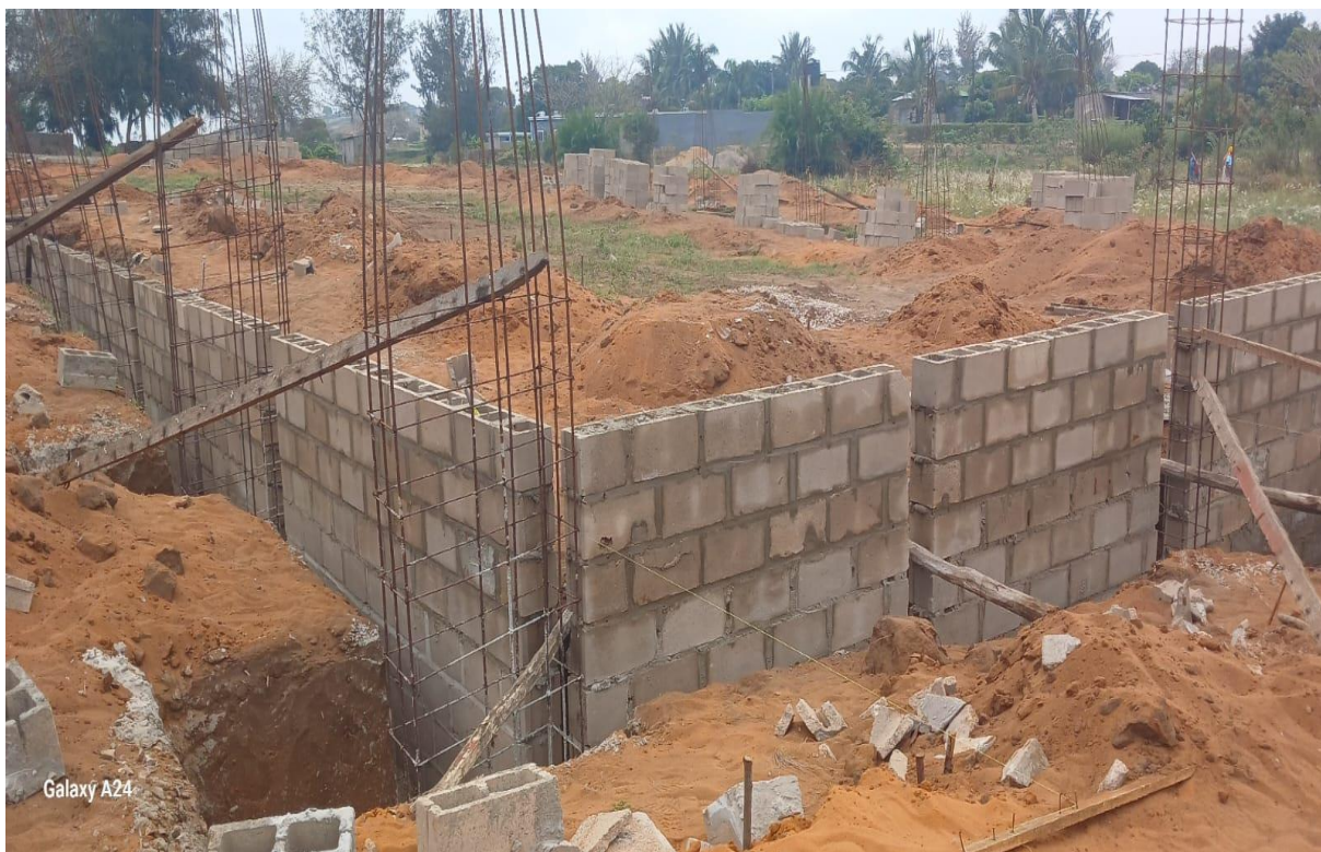
Alinhamento de blocos da fundação
