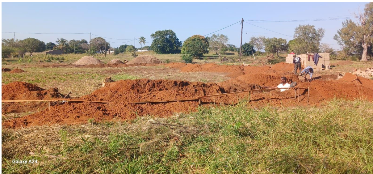
Início das escavações
