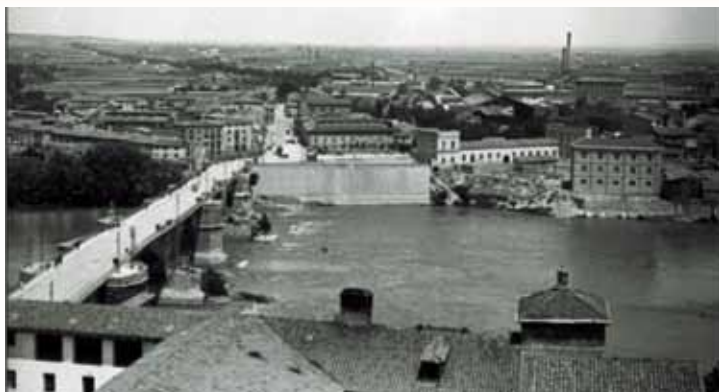
© A.H.P.Z.-ES/MF/REQUEJO 04/0269-71. Puente de Piedra desde la torre de LAseo [La Seo]. Julio Requejo. 1922-06-05.
