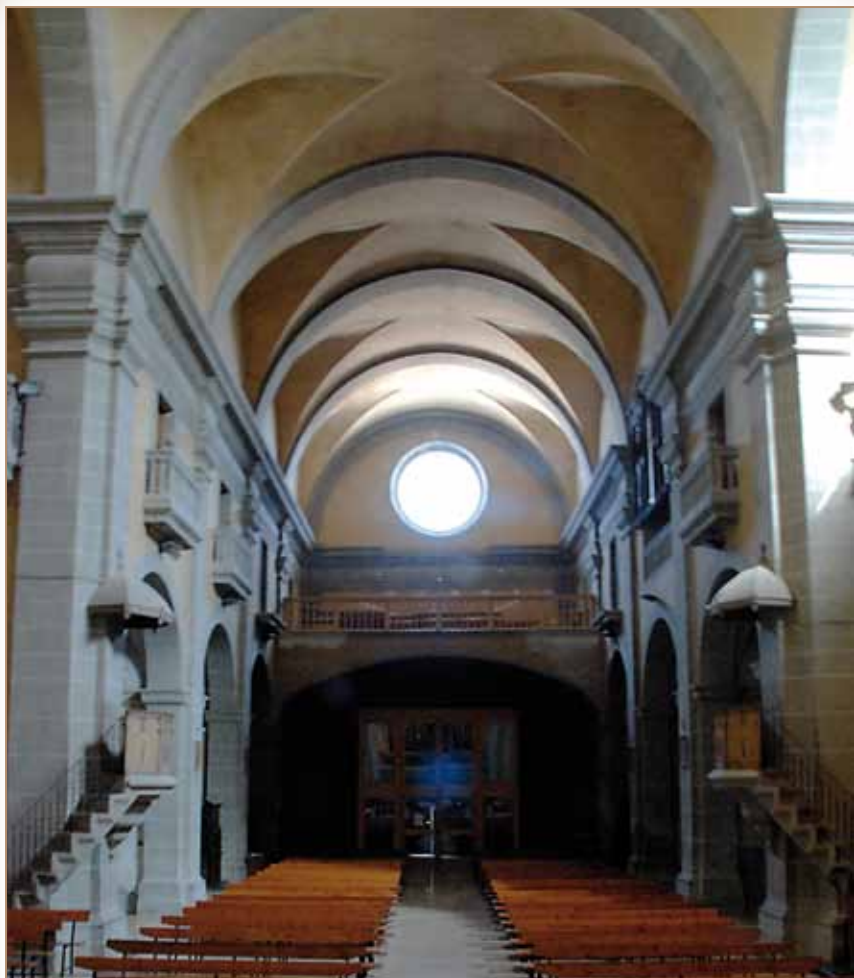
Nave central de la iglesia.
